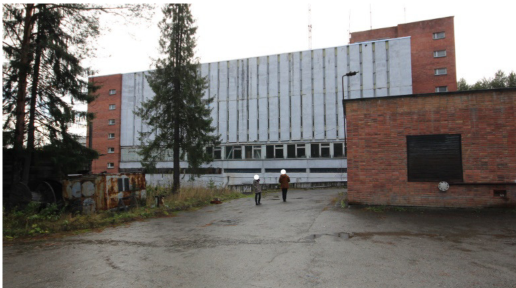
Рис. 1. Здание АТС в городе Нижняя Тура
